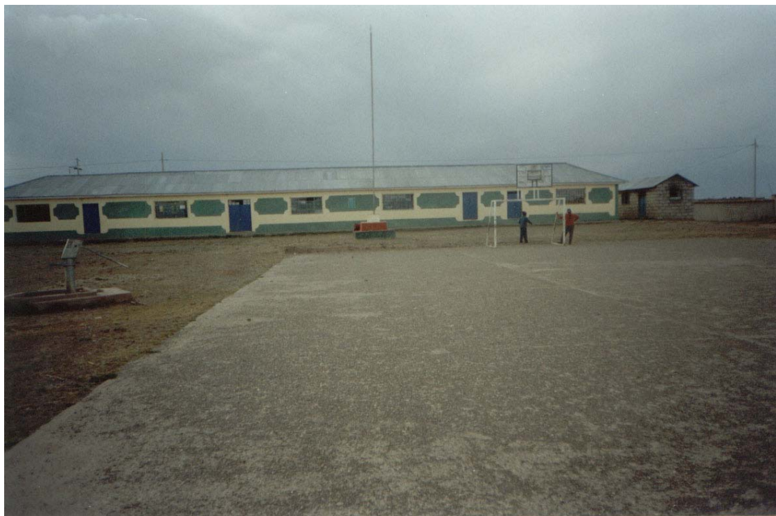
Local Comunal y aulas de PRONOEI de la comunidad de Huariquisana
